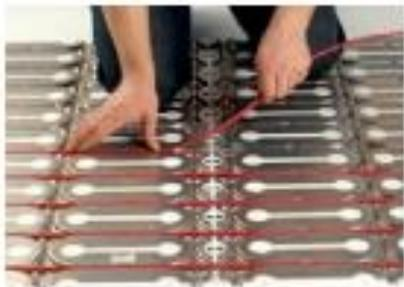
4с. Подходит ТОЛЬКО при использовании кабеля толщиной не более 3 мм. Мощность теплового излучения должна составлять не более 140 Вт/м<sup>2</sup>.
