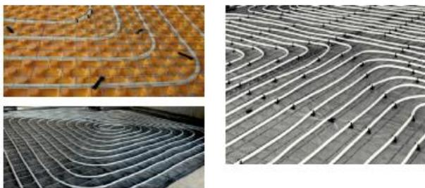
1b. Требуется стяжка толщиной не менее 20 мм выше труб, т.к. нагревающий элемент теплого пола расположен близко к напольному покрытию.
